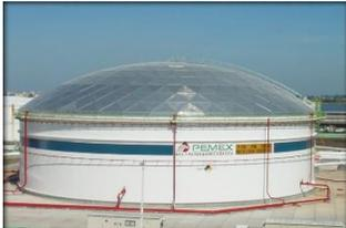
**Tanque atmosférico con domo geodésico**
